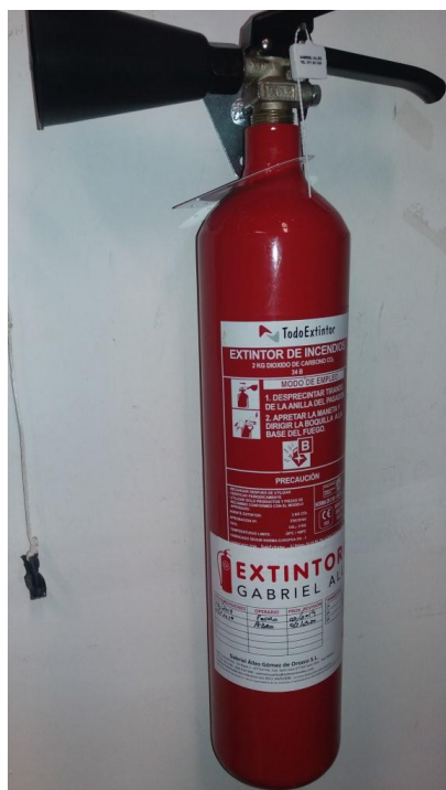
Foto 5: Extintor CO2, con la pegatina de la empresa mantenedora y revisado.
