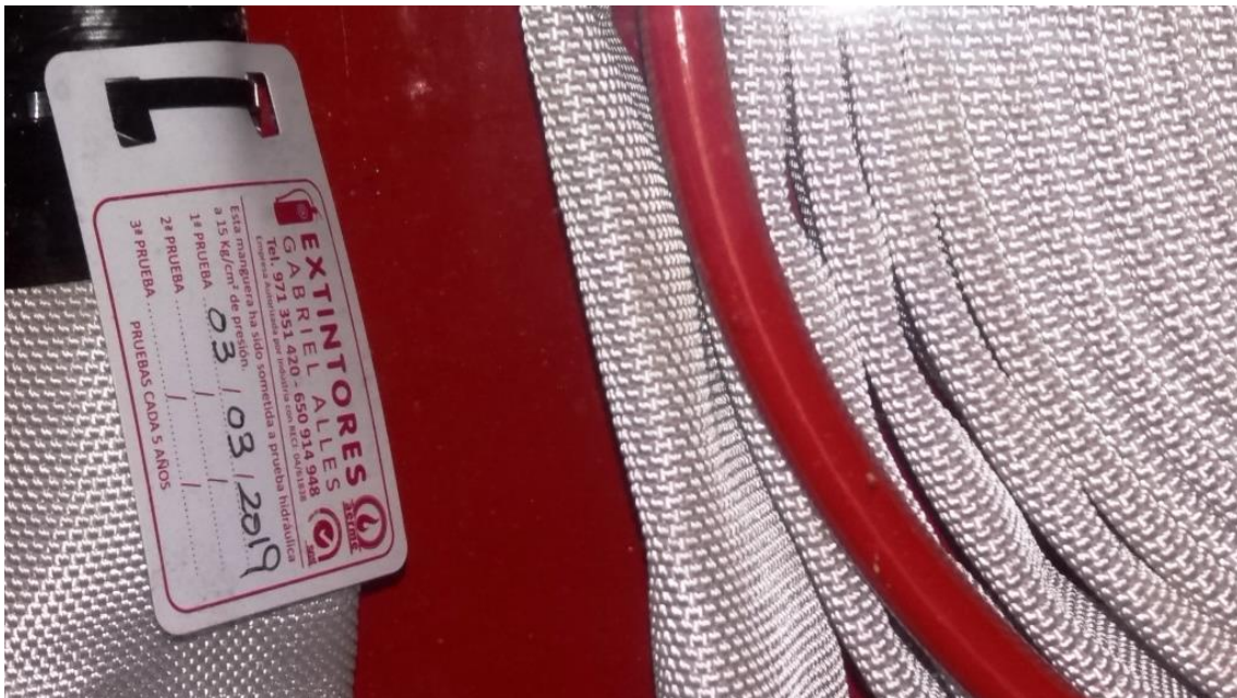
Foto 6: B.I.E, con la pegatina de la empresa mantenedora y revisado.
