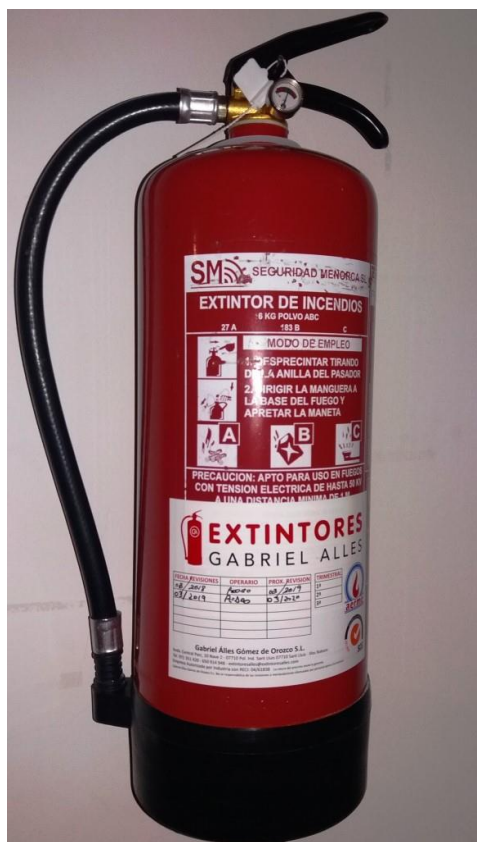
Foto 4: Extintor 6 kg Polvo ABC, con la pegatina de la empresa mantenedora y revisado.
