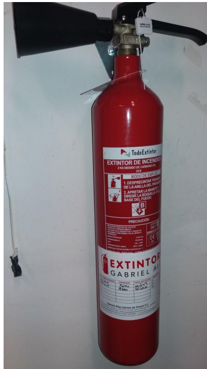
Foto 5: Extintor CO2, con la pegatina de la empresa mantenedora y revisado.
