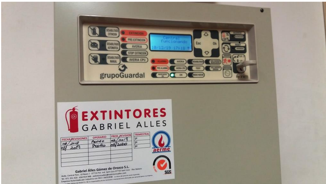
Foto 3: Centralita de alarma de incendios, con la pegatina de la empresa mantenedora.
