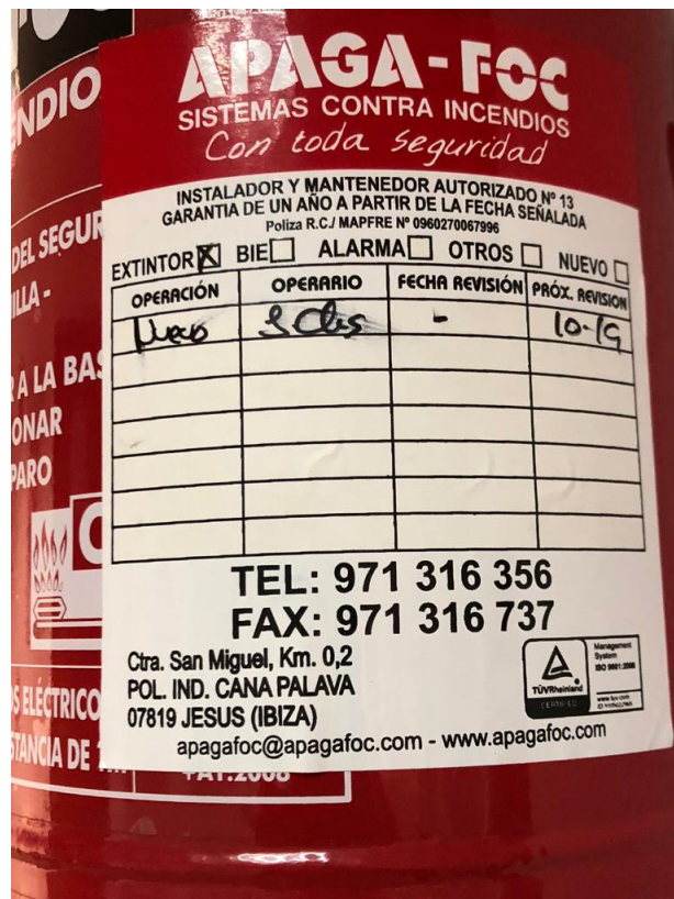
Foto 6B: Extintor ampliación pegatina de la empresa mantenedora.
