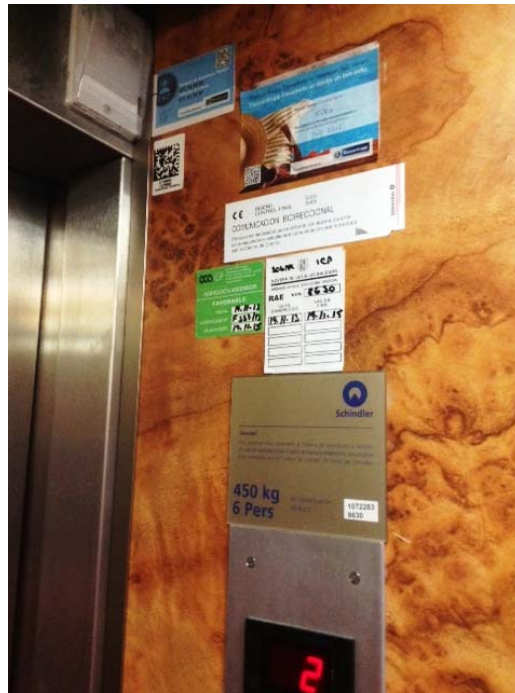
Foto 6: Ascensor con pegatina de Organismo de Control, con fecha de las inspecciones.
